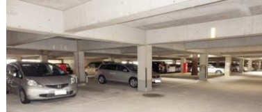
■屋根付駐車場・防犯カメラ有！
